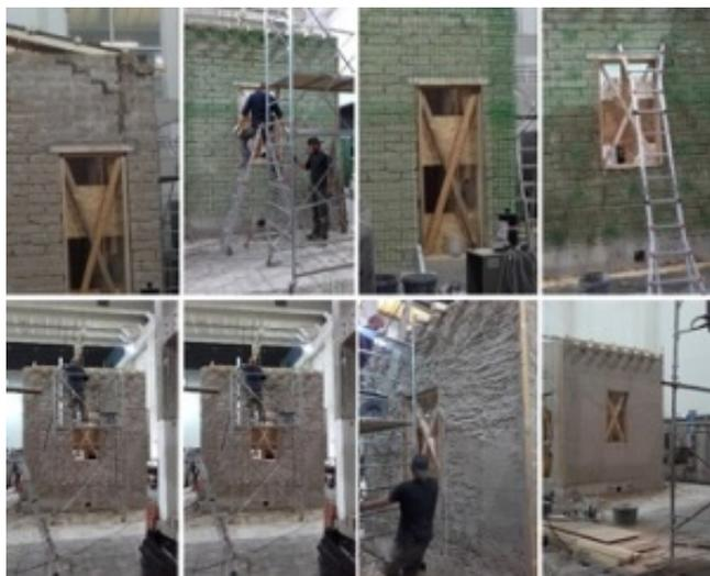
Sequenza della riparazione/rinforzo con tecnologia Fibrenet della struttura ad U. Si noti la rete di rinforzo di colore verde (foto: ENEA)
